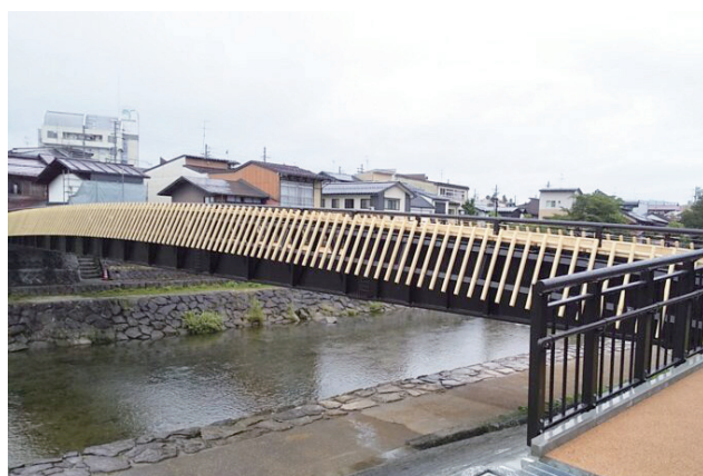
▲三丁目商店街と宮川朝市を結ぶ行神橋
