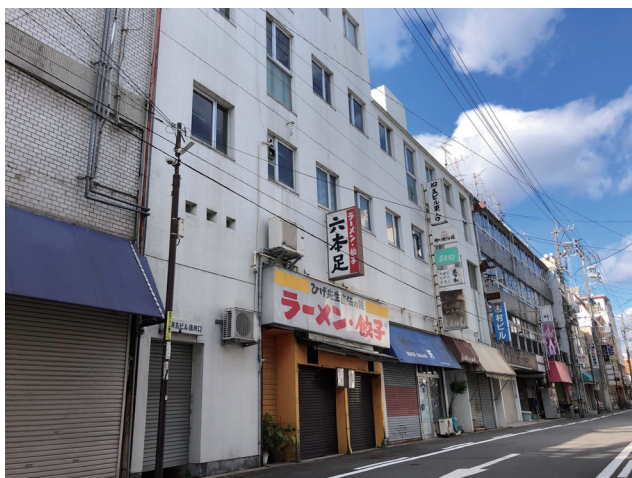
▲再開発の検討を進める予定の西柳ヶ瀬の空きビル
