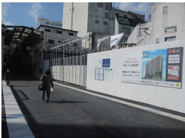
▲着々と進む高層マンション建設現場
